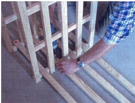
**6** - Maintenir les parties verticales parallèles en fixant des barres de liaison pré percées tout en haut du meuble (sauf pour les 735 et Combi à l'avant dernière rangée car ils ne possèdent aucune barre de liaison tout en haut).
