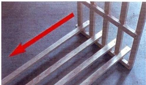
**5** - Aligner le milieu du tasseau horizontal avec les trous des barres de liaison pré percées et visser.
